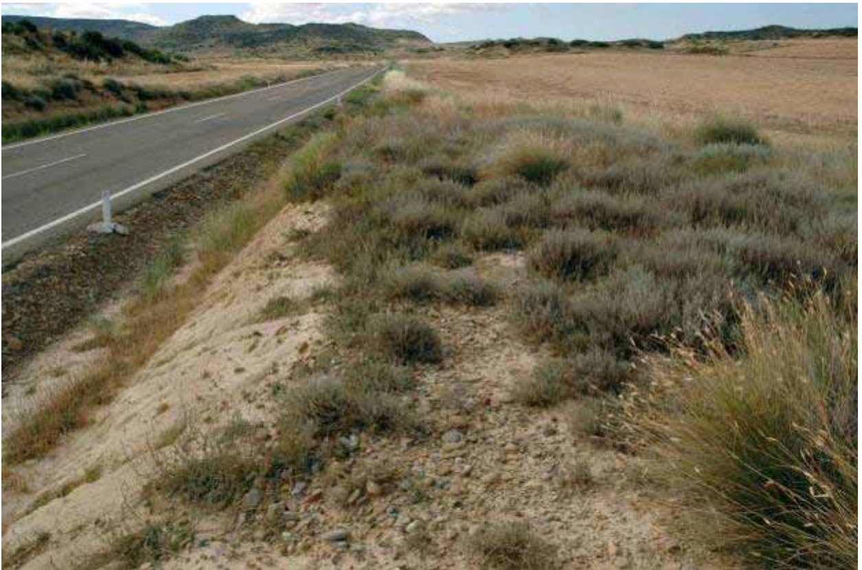
Las gravas de la vía romana en Castiliscar, junto a la actual carretera A-127.
