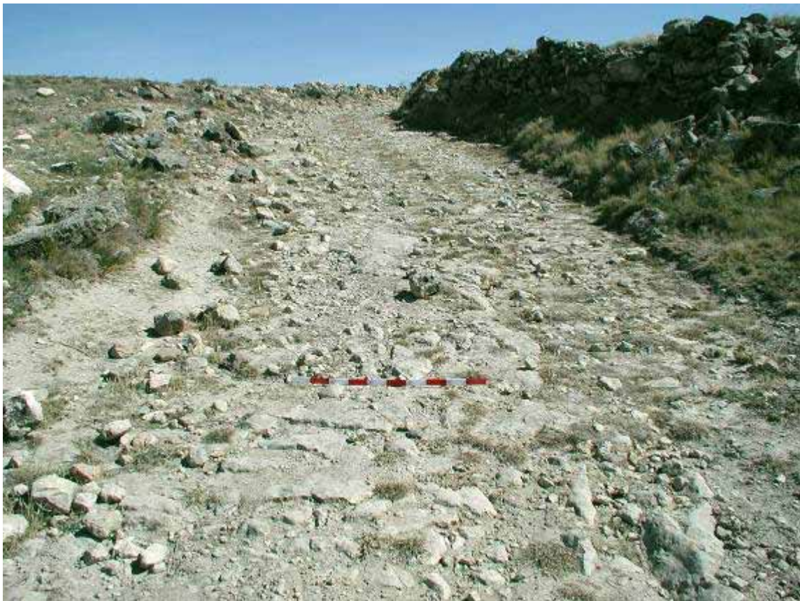
Cimentación del camino en la Carretera Vieja de Borja a Tarazona, cerca del corral de las Ventas. Vestigio hoy desaparecido.
