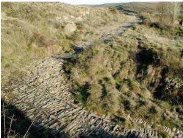
Detalles constructivos del Camino Viejo de Undués de Lerda a Ruesta. Considerado romano por algunos y señalado expresamente así, se trata de un camino de mulas de características modernas.
