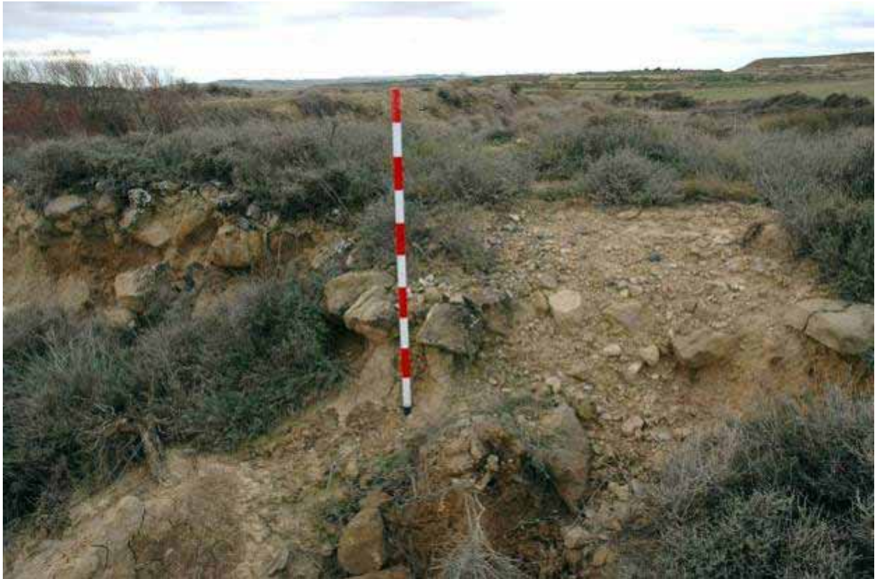
Sección de la vía romana en el Fitral, Castiliscar. Cimentación de piedras gruesas areniscas y el paquete de zahorras superior. Las gravas no se encuentran de forma natural en este terreno.
