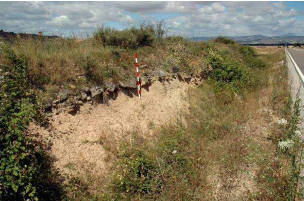
Sección longitudinal de la vía romana en Sos del Rey Católico, junto a la carretera A-127 dirección a Sangüesa.
