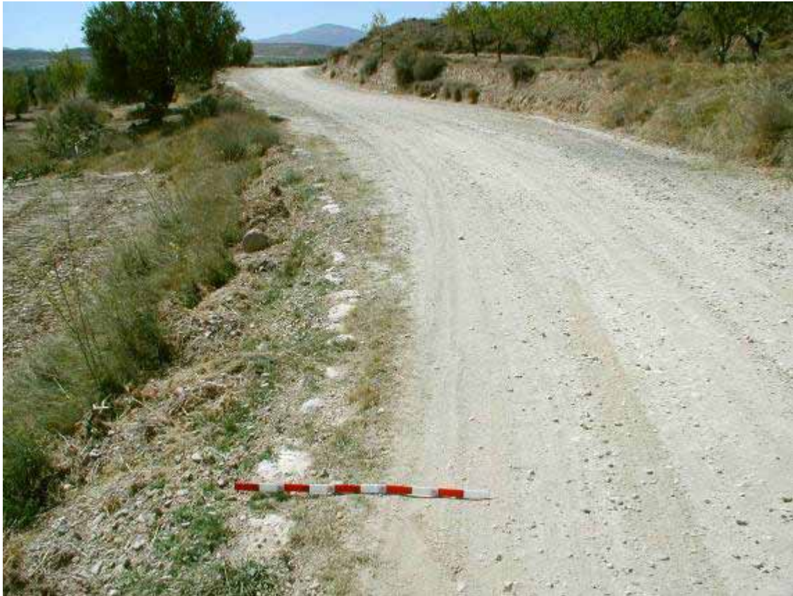
Bordillo de la infraestructura de la Carretera Vieja de Borja a Tarazona, a la vista tras el paso de maquinaria de nivelación. Vestigio hoy desaparecido.
