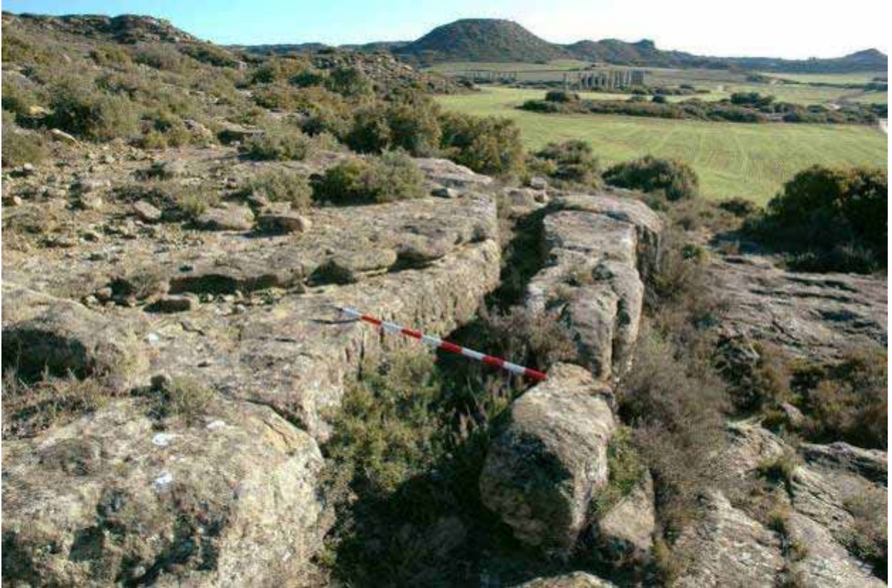
Tramo de canal excavado en la roca. Al fondo, los pilares del acueducto.
