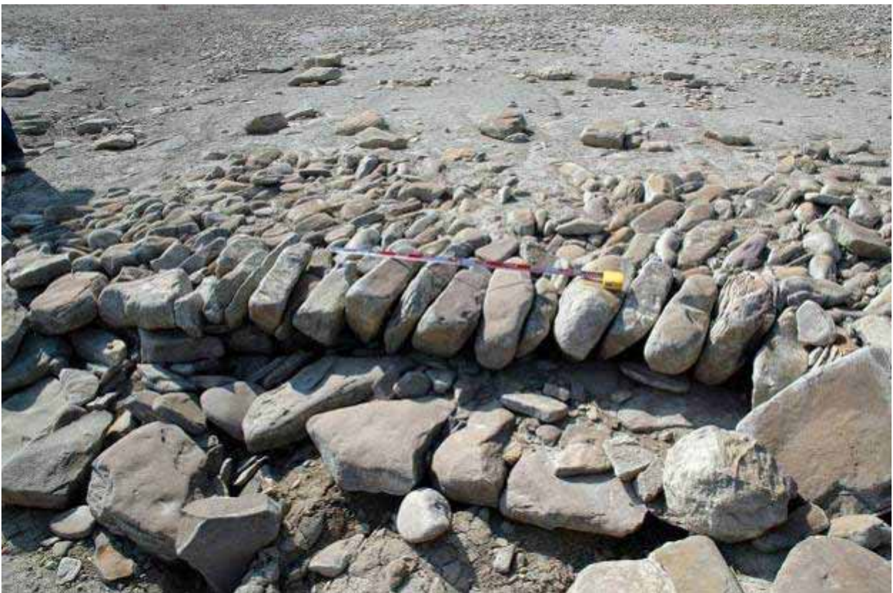
Detalle del empedrado de cimentación del Camino Viejo de Tiermas a Ruesta. Periodo de aguas bajas del embalse de Yesa de marzo de 2005.
