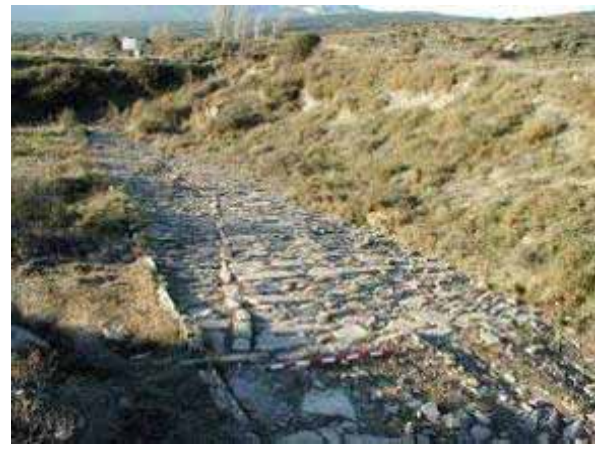
Detalles constructivos del Camino Viejo de Undués de Lerda a Ruesta. Considerado romano por algunos y señalado expresamente así, se trata de un camino de mulas de características modernas.
