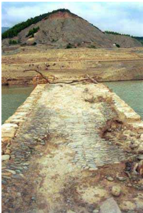
Detalle del pavimento del puente viejo de Tiermas. Periodo de aguas bajas del embalse de Yesa de octubre de 2001. Foto: J. L. Ona.
