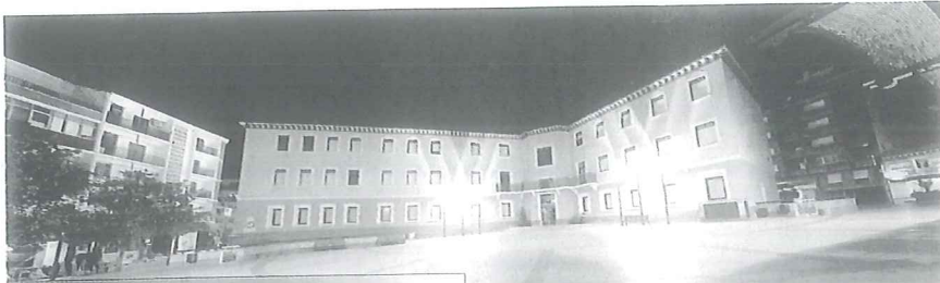
Iluminación de la Plaza de la Villa en Ejea.
